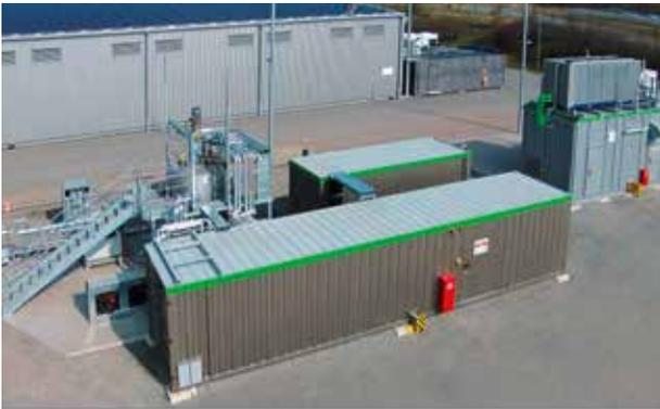
Die Anlage in Allendorf erzeugt mittels biologischem Verfahren aus regenerativem Strom Methan, das ins öffentliche Erdgasnetz eingespeist wird; Foto: Viessmann
