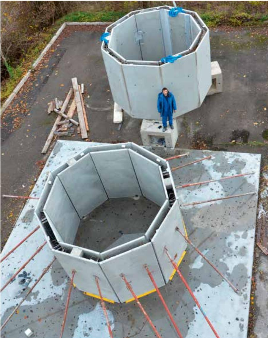
Die ringförmigen Segmente mit einer Außen- und einer Innenwand vor dem Aufbau. Die hohlen Beton-Doppelwandelemente werden mit Hilfe eines Krans exakt aufeinandergestapelt und dann vor Ort mit Beton ausgegossen
