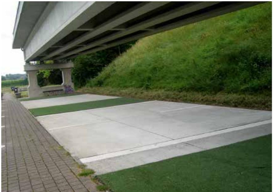
Unter der Brücke ist die Autobahn im Querschnitt der 30er Jahre nachgebildet.
