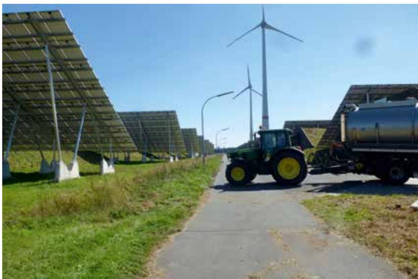
Photovoltaikanlagen mit einer elektrischen Leistung von 6 MWpeak, sieben Windkraftanlagen, eine Biogasanlage und eine Bioabfallbehandlungsanlage erzeugen Energie im Bioenergiepark in Saerbeck.
