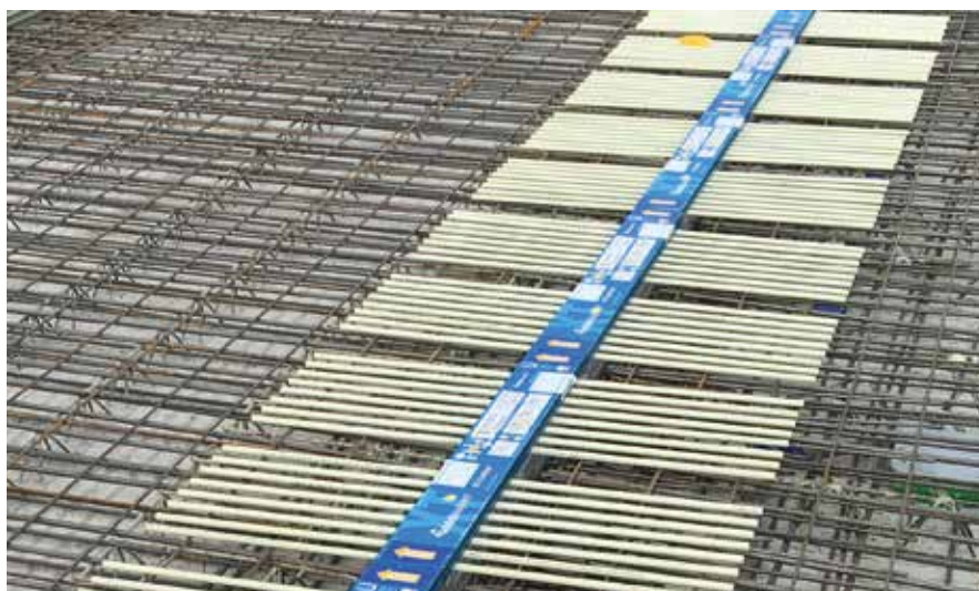
Mit dem Schöck Isokorb XT-Combar können Wärmebrücken beispielsweise am Anschluss von Balkonen auf ein Minimum reduziert werden.
