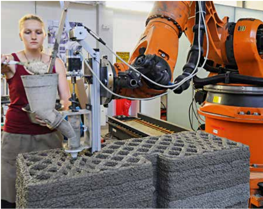
3D-Druck mit Beton: An der Versuchsanlage für additive Fertigung wird durch Extrusion von Holzleichtbeton ein multifunktionales Wandelement hergestellt.
