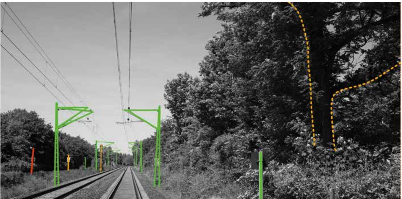
Von den Kameras eines Triebfahrzeugs erzeugte Videodaten werden in 3D-Modelle der Strecke umgewandelt. Der Vergleich mit Modellen, die aus älteren Videodaten erzeugt wurden, erlaube es, Veränderungen zu detektieren. So werden Sicherheitsrisiken, zum Beispiel durch umsturzgefährdete Bäume, frühzeitig erkannt.
