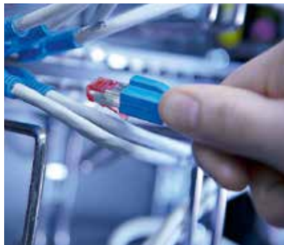
Moderne Glasfaserkabel übertragen verschlüsselte Informationen zwischen Stellwerken und dem Außenbereich der Infrastruktur.
