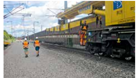
Bauarbeiten: Auf dem gereinigten Grundsotter werden vormontierte Weichen verlegt.
