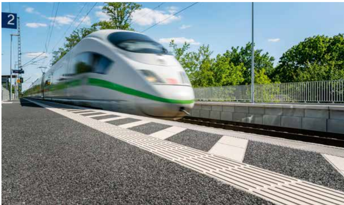
Fertiger Modulbahnsteig für den HP Oberhausen-Holtten
