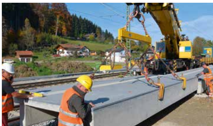
Schnelle Montage durch modulare Bauweise
