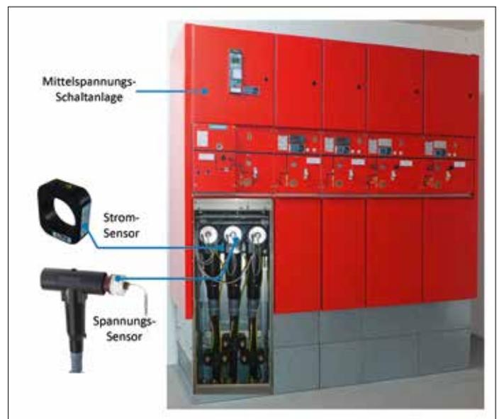
MS-Schaltanlage in einer ONS mit Zelisko-U/I-Sensoren im Kabelanschlussraum.
