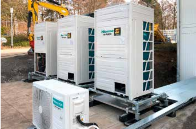
Bodenmontage der PAC- und VRF-Außeneinheiten.
