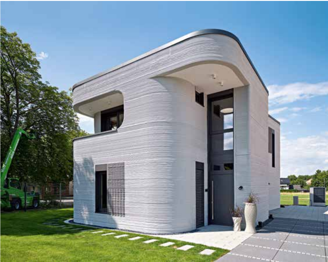
Zukunft des Bauens? Das erste in 3D-Beton- druck gefertigte Haus Deutschland steht in Beckum.
