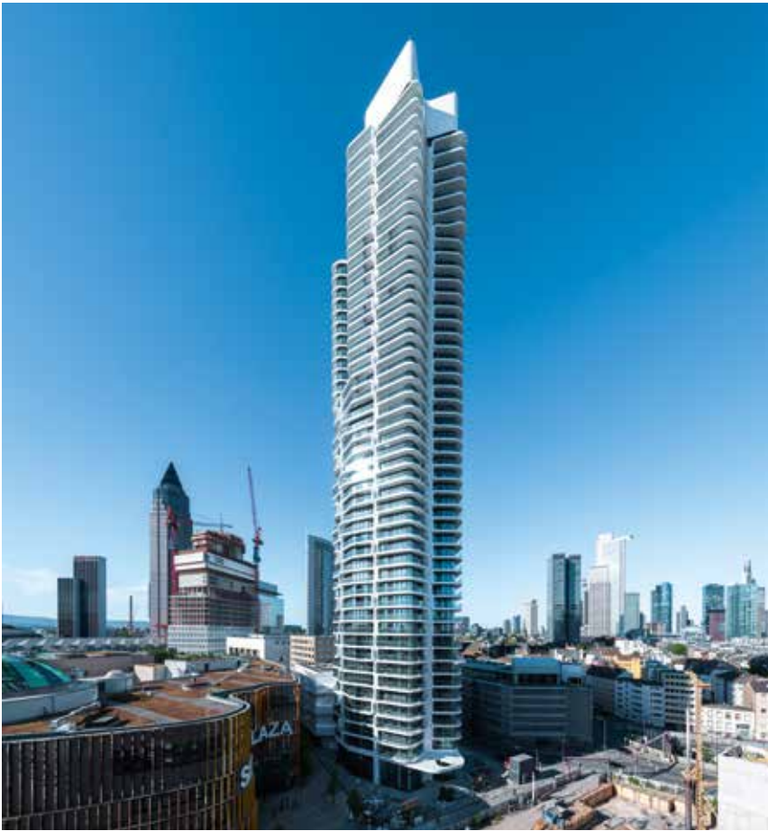
Mit 180 m ist der Grand Tower in Frankfurt am Main das höchste Wohnhochhaus Deutschlands.
