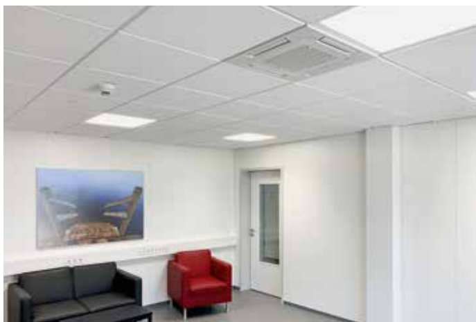
Optimale Integration der Kassettengeräte in die Odenwalddecken.
