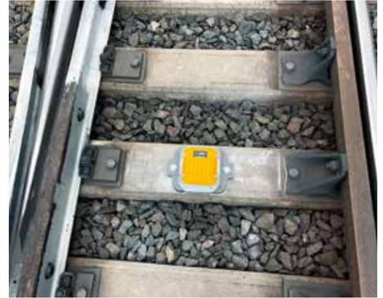
Sensorboxen messen an den Betonschwellen Vibrationen und Temperaturen
