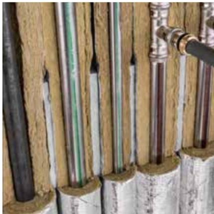
Die Dämmung mit komprimierter Mineralwolle erspart Arbeitszeit und Kosten.
