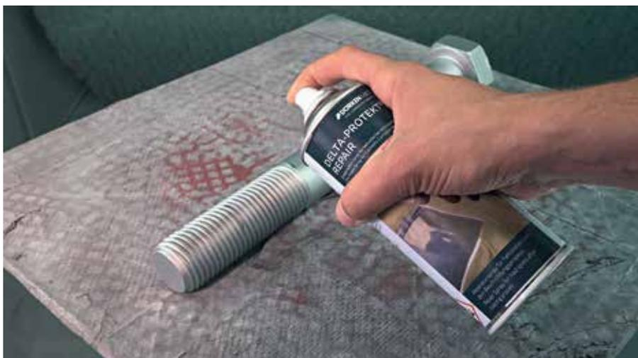
Mit Hilfe der Spraydose und den raumtemperaturhärtenden Zinklamellenüberzügen lassen sich auch Transport- oder Montagebeschädigungen nachträglich ausbessern.
