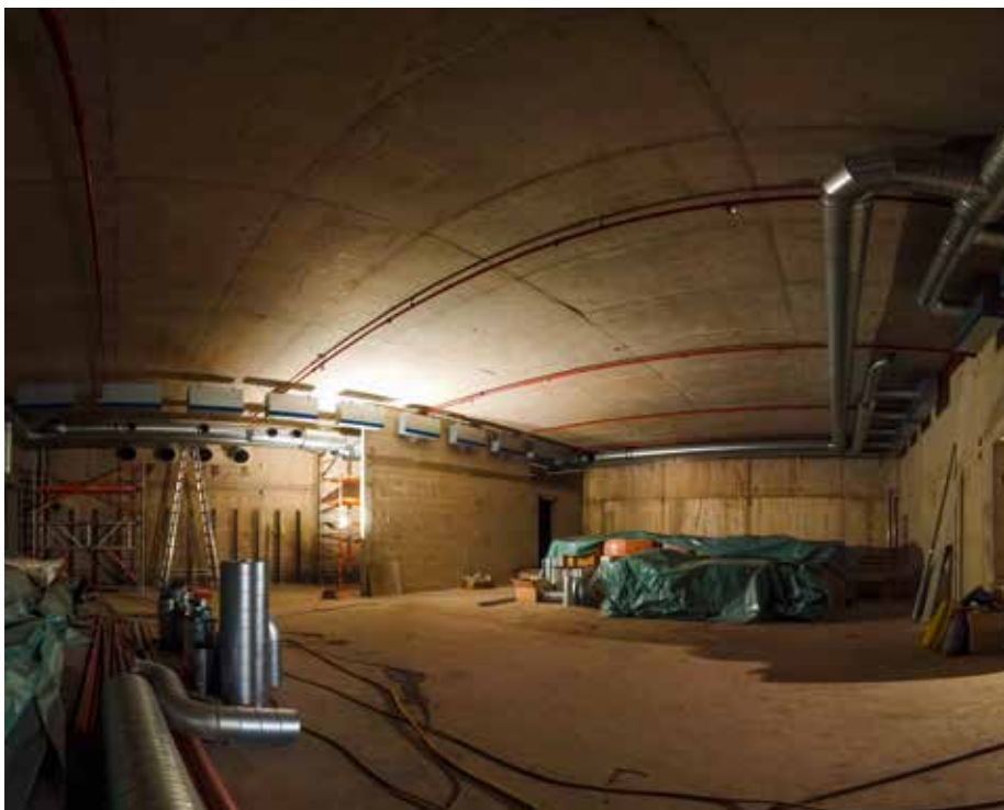
Hier entsteht im Bunker ein Dancefloor.
