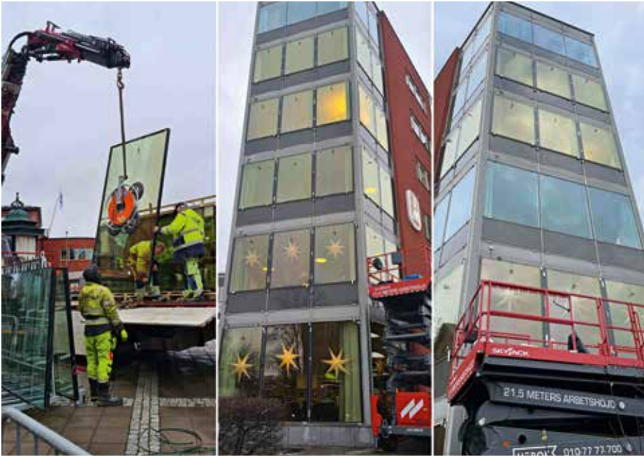
Installation erster Isolierglaseinheiten mit schaltbaren, elektrochromen Schichten in Uppsala, Schweden.
