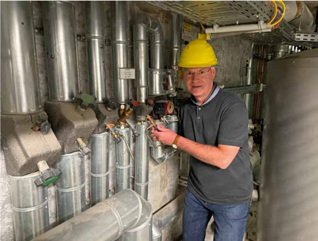
In Trinkwasser-Installationen müssen geeignete und repräsentative Probenahmestellen vorhanden sein. Dipl.-Ing. Frank Kasperkowiak inspiziert technische Details an der Trinkwasser-Installation.
