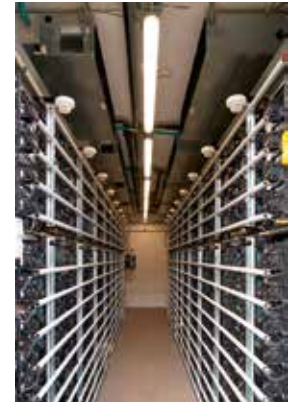
Ein bestückter Container, an der Decke die VRF-Kanalgeräte von Panasonic.
