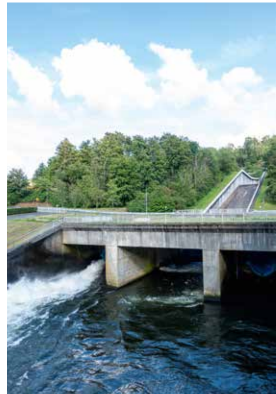
Mit zwei Wasserkraftanlagen produziert der Wupperverband an der Wupper-Talsperre Strom.
