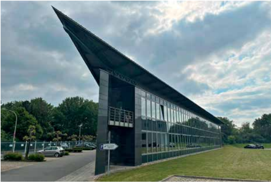
Büro des Emscher-Lippe BV, des Westfälischen BV und des Lenne-BV im Office-Center Vogelsang, Hagen.
