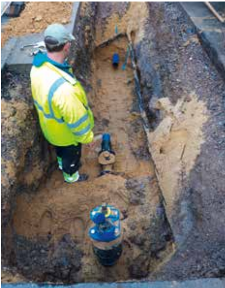
Michael Baukhage vom Wasserversorgungsbetrieb Balve inspiziert die Überdeckung von Leitungen unter Berücksichtigung der Schutzziele Eindringtiefe des Frostes sowie Erwärmung des Erdreiches durch Sonneneinstrahlung.
