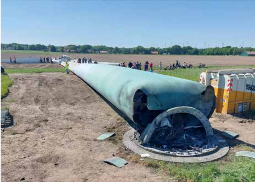
Punktlandung: Die gesprengte Anlage liegt am Boden, bestaunt von vielen Schaulustigen.
