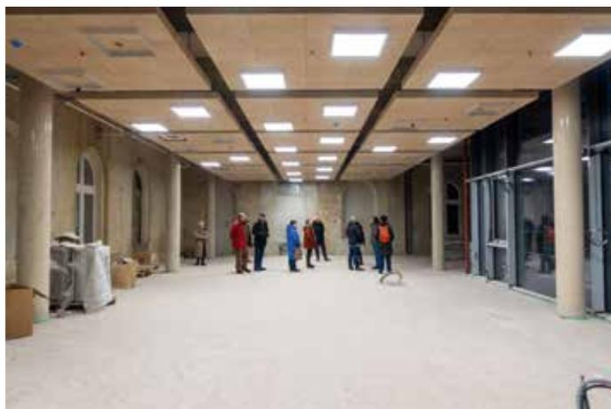
Holzwoleplatten an der Decke zur verbesserten Wärmedämmung und Akustik.
