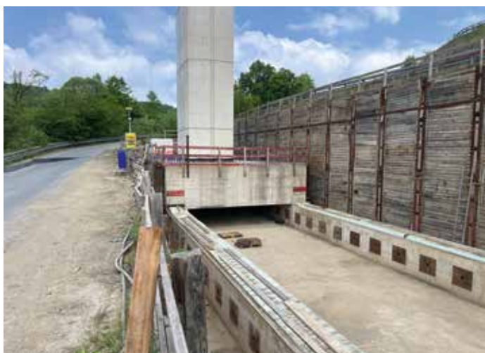
Verschubeinrichtung von Pfeiler Nummer 3 mit 70 Meter hoher Stütze.
