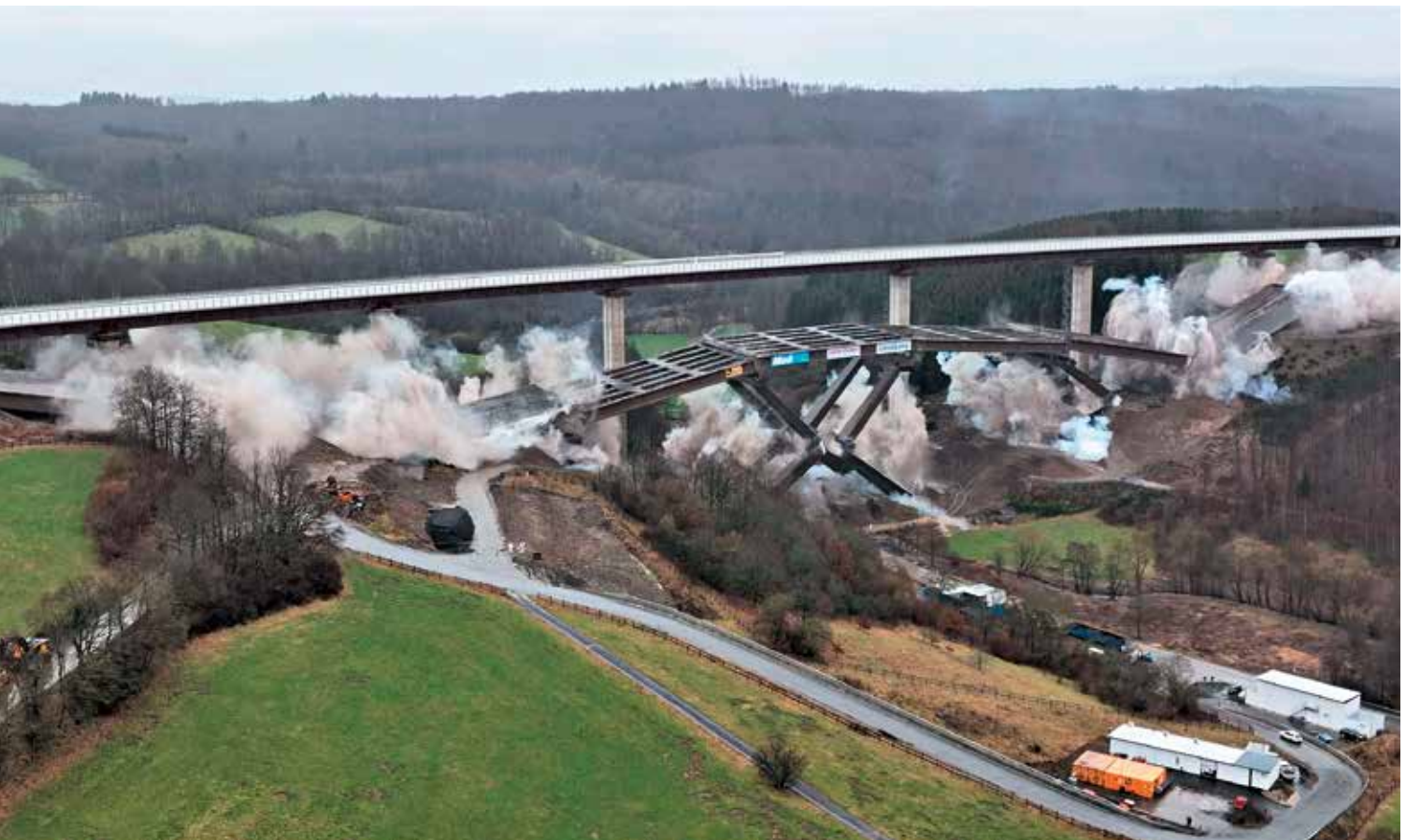
Sprengung der alten Brücke.
