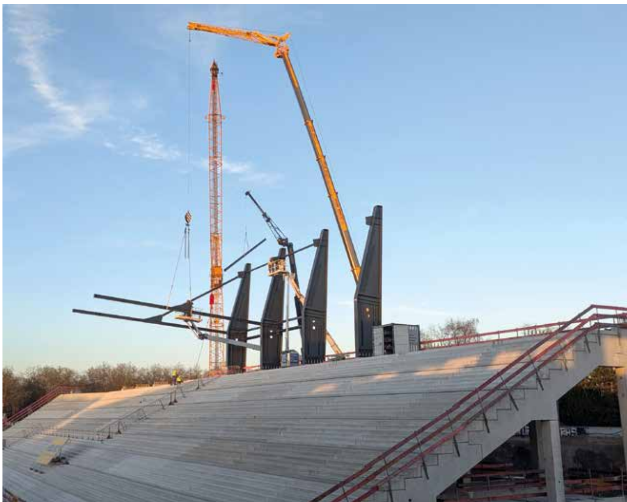
Montage der Dachkonstruktion der Osttribüne des Preußenstadions.
