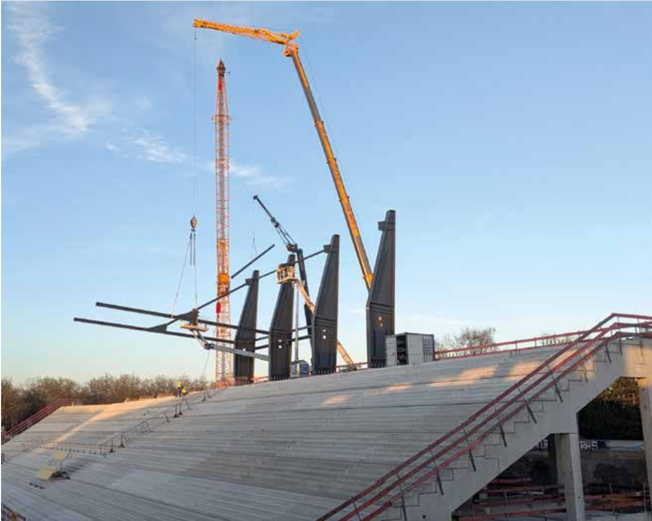
Montage der Dachkonstruktion der Osttribüne des Preußenstadions.
