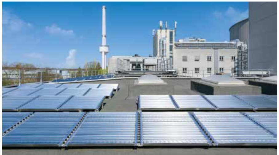
Mit der Photreon-Photoreaktortechnologie lässt sich inhärent grüner Wasserstoff kostengünstig direkt am Ort des industriellen Abnehmers herstellen.
