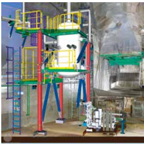
Anlagenscan mit 3D-Modell-Kondensatsammelbehälter.
