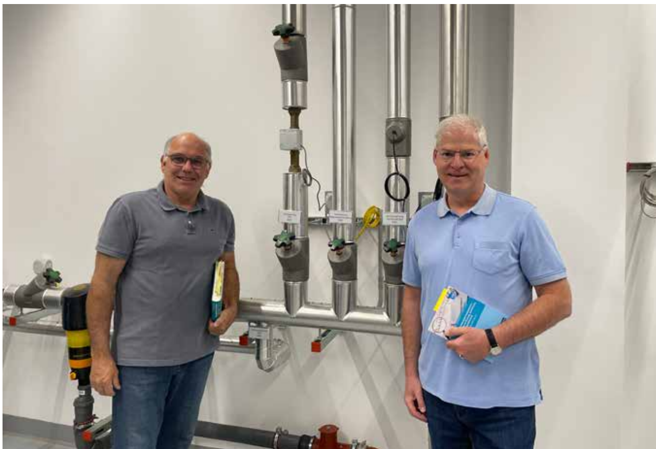
In einer Technikzentrale inspizieren Burkhard Henschel (l.), Installateur- und Heizungsbauermeister und Dipl.-Ing. Frank Kasperkowiak die Trinkwasserinstallation nach den Anforderungen der Richtlinie VDI 6023.
