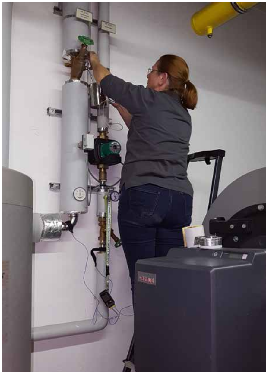
Geeignete Stellen für eine sichere und regelwerkskonforme Proben-Entnahme sollten leicht und möglichst ohne Hilfsmittel zugänglich sein bzw. Steighilfen zur Verfügung stehen, berichtet Alexandra Bürschgens.
